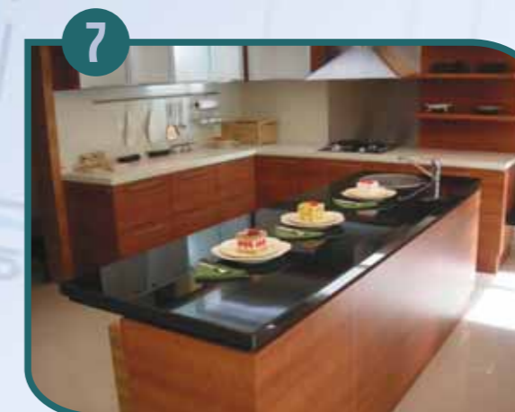
7 Le comptoir est installé.
