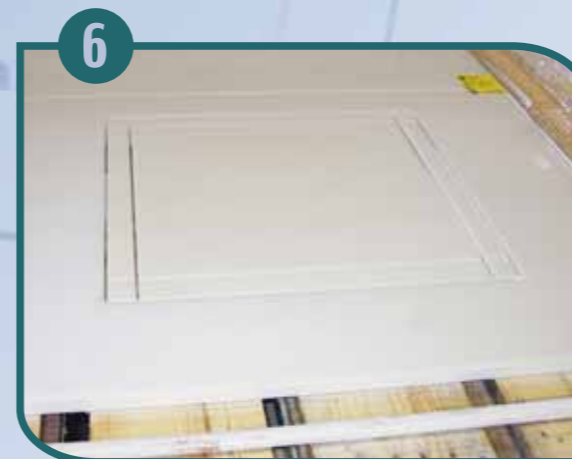
6 Taglio dei mobili e degli impianti in conformità con le istruzioni del disegno elettronico computerizzato.
